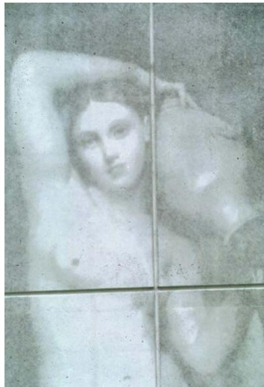
Idéal pour la réalisation de panneaux préfabriqués avec photogravure béton selon le procédé SERILITH de PIERI
